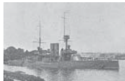
Pansarskeppet Oden (1898) i kustskadern 1903. Fartyget hade ett displacement på 3500 ton och gjorde 16 knop. Thor (1899) var av samma klass men 200 ton mindre.
