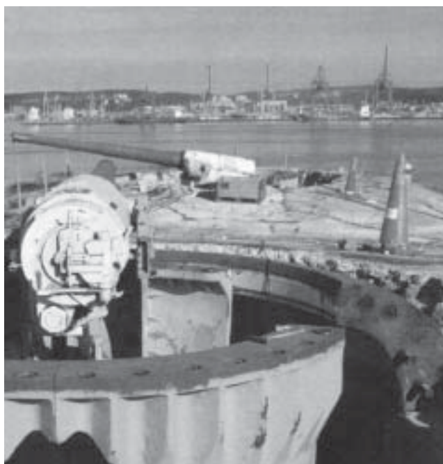
Arbete med att återmontera 15,2 cm pjäs från Styrso. SFV 2004
